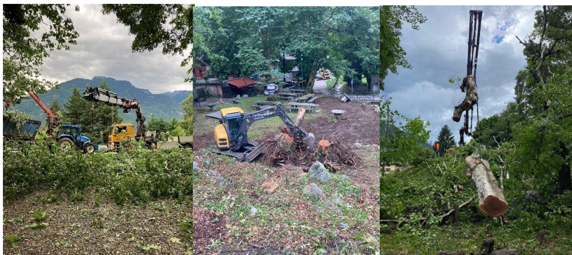
Lavori di ripristino
